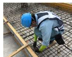
写真 1 実物大高架橋 埋設センサ設置状況
