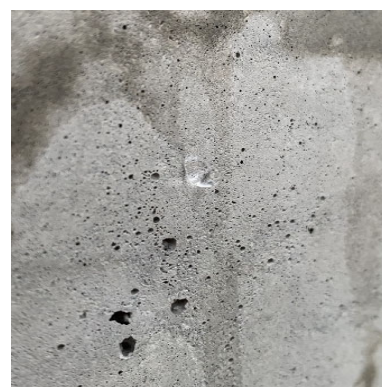
写真-4 試験体表面の撥水状況
