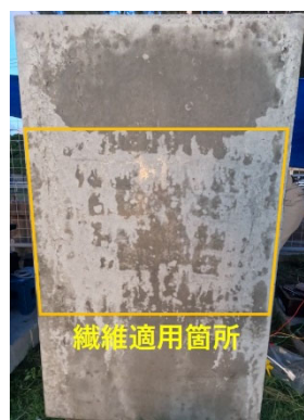
写真-3 散水後の濡れ状
