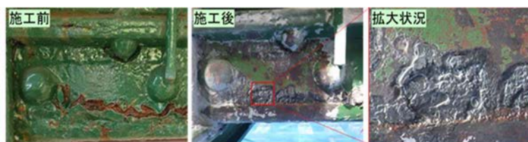
図-3 ドライアイスブラスト施工前と施工後の比較
