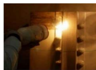
写真-4 レーザーケレン
