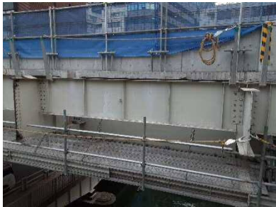
図-3 撤去前の増設縦桁
