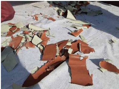
図-2 剥離後の塗膜
