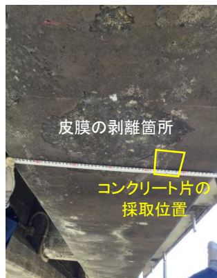
図 2 コンクリート片 採取位置の外観
