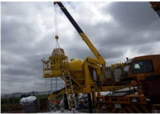
モバイルプラントによる練混ぜ
