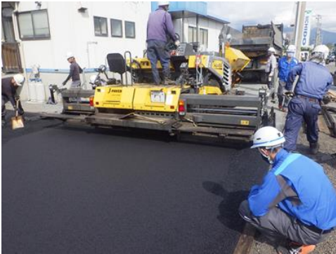
写真2 ストアス工区の試験施工状況
