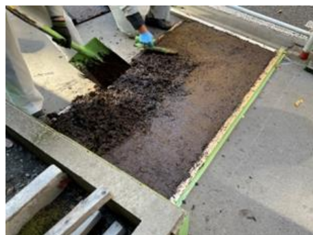
写真-3 施工状況
