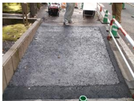
写真-4 養生完了
