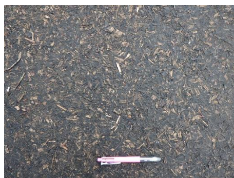
写真-5 木質調の出た舗装表面
