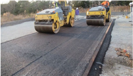
写真-1 表層の初期転圧状況
