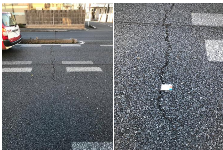
写真 2 近接目視による確認結果（国道 17 号）
