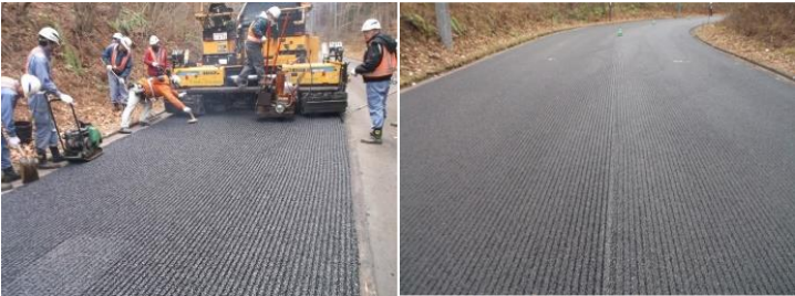
写真-3 CAE 路盤上 FFP 施工状況 (1 層施工 t=50\text{mm} )
