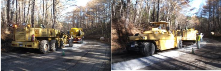
写真-2 CAE 路盤施工状況
