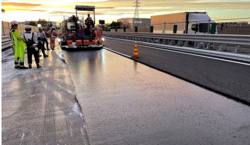
写真-1 施工状況
