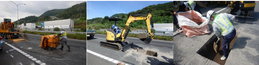
写真-1 （左）アスベースの切断、（中）アスベースの撤去、（右）路盤採取状況
