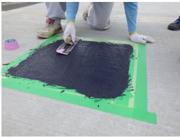
写真-1 当該補修材の施工状況
