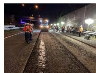
写真-3 転圧状況
