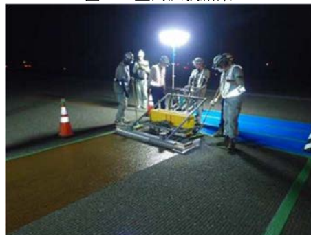
写真-2 現場施工状況
