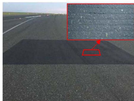
写真-3 施工 11 か月後の状況
