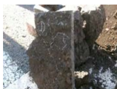
写真-2 基層底面
