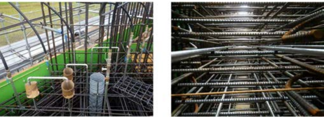
写真-1 クーリングパイプ配管状況
