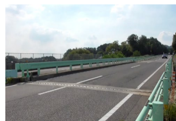
図-1 対象橋梁の写真
