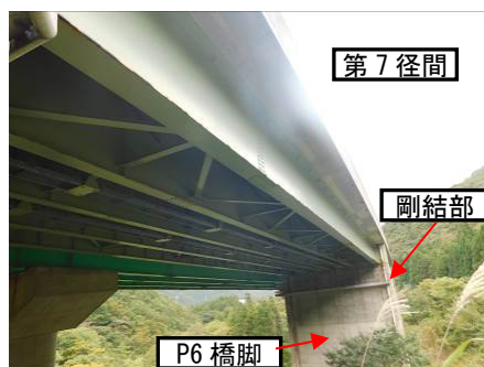
写 1 対象橋梁(2 連目・A2 側より)
