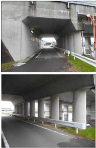
図 1. 対象箇所（施工前）
