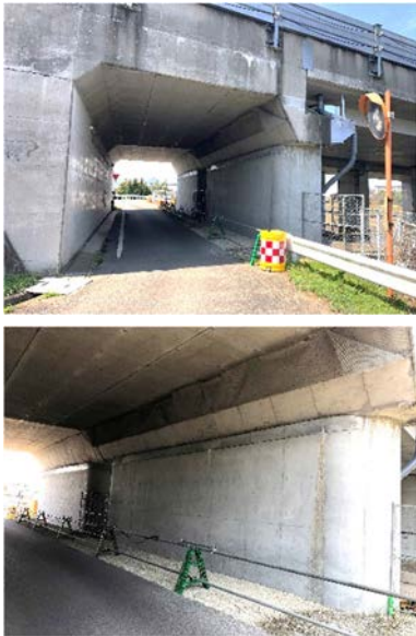
図 6. 対象箇所（施工後）
