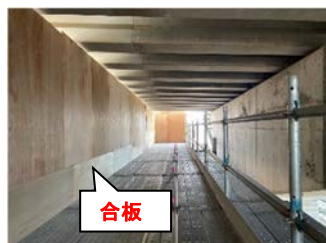
写真6 飛散養生対策
