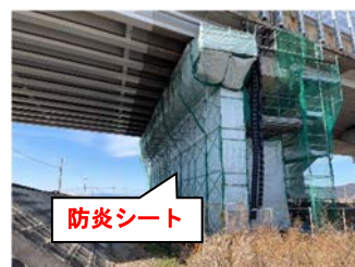
写真5 飛散養生対策
