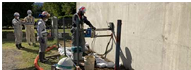
図 2 コアボーリングマシンによる削孔状況
