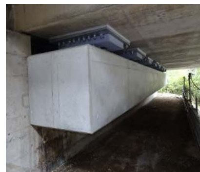
写真-3 施工完了
