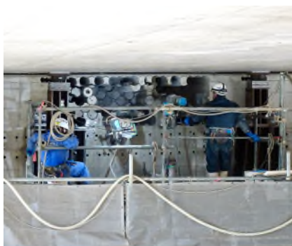
写真-1 橋台取り壊し
