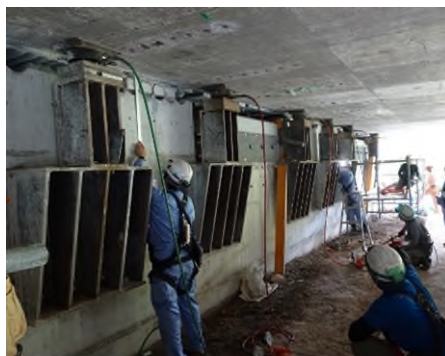
写真-2 ジャッキアップ
