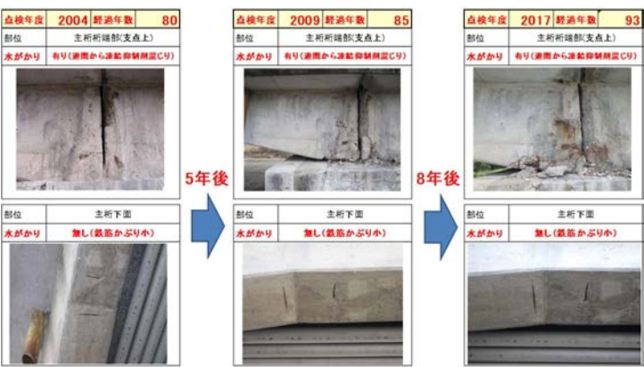
図-2:1920 年代竣工の RCT 桁(内陸部)の例 上下段とも同一橋梁
