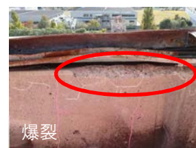
図-3 火害程度「大」の変状例
