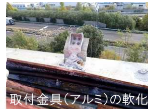
図-3 火害程度「大」の変状例
