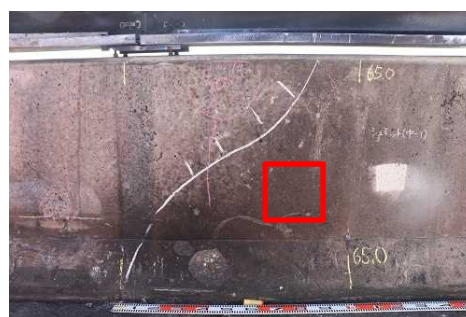
図-2 火害程度：中（すすの付着）
