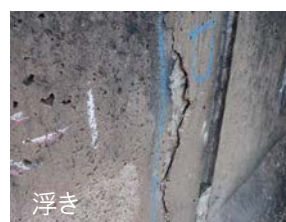
図-2 火害程度：中（すすの付着）
