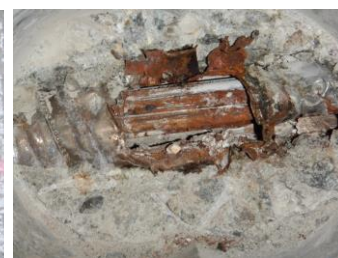
図5 D橋のPC鋼線
