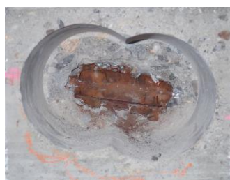
図4 T橋のPC鋼棒
