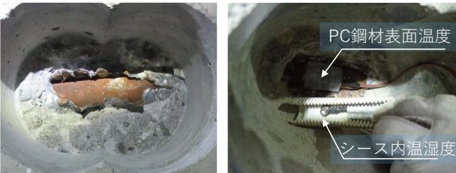
図 1 シースの開削状況 図 2 センサ類の配置
