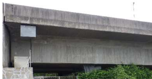
図-1 調査対象橋梁
