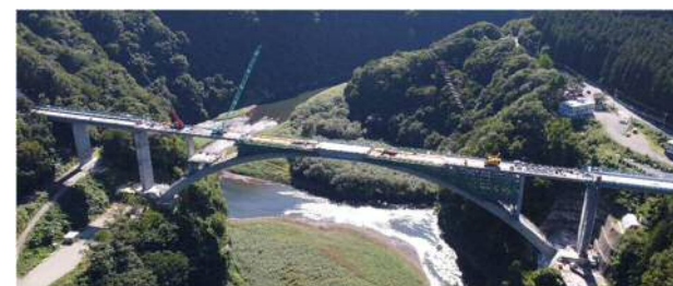
写真 3 補剛桁の施工
