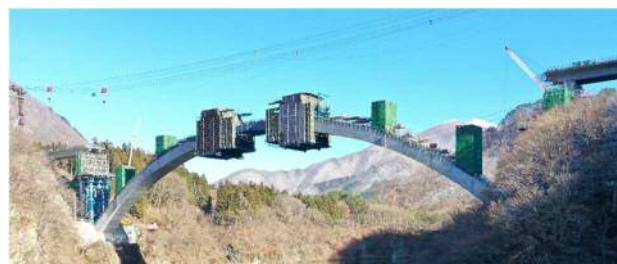
写真 2 アーチリブと鉛直材の同時施工
