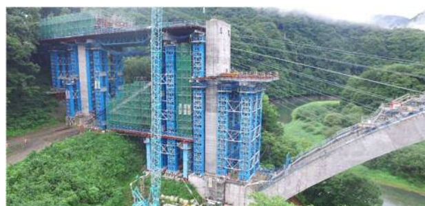
写真 1 アーチリブと補剛桁の同時施工
