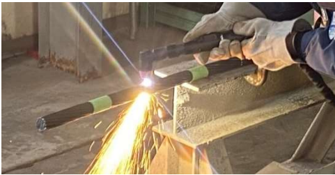
写真-1 プラズマ切断の状況
