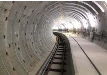
写真－3 インバート施工完了
