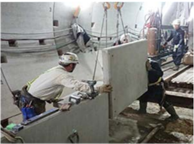
写真－2 L型擁壁設置状況
