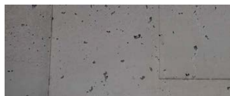
写真-4 透気性評価「劣」の測定面
