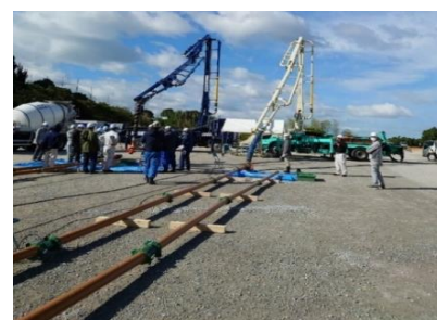
写真-2 2 系列による圧送配管
