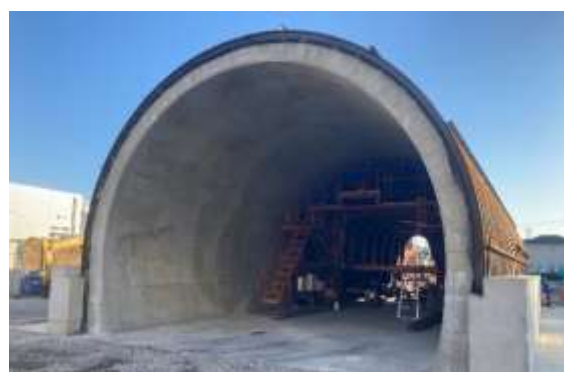
写真-2 脱型後の覆工コンクリートの状況
