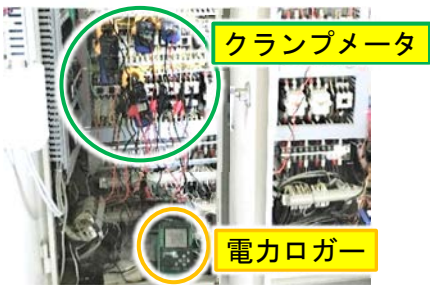
写真－1 計測器の設置状況
