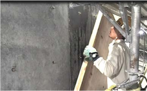
写真-3 型枠の取外し状況
