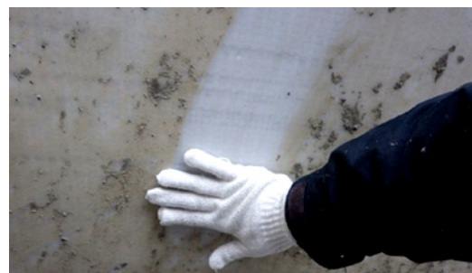
写真-1 スキン材表面の拭取り清掃
