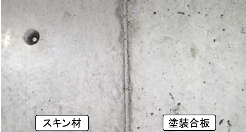
写真-5 コンクリートの仕上がり
