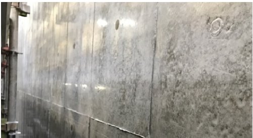
写真-7 コンクリートの仕上がり (5 回)
