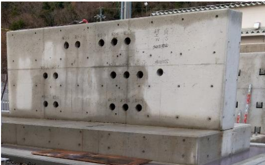
写真-1 実証試験体
