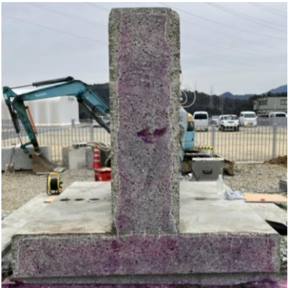
写真-3 実証試験体の炭酸化深さの確認状況
