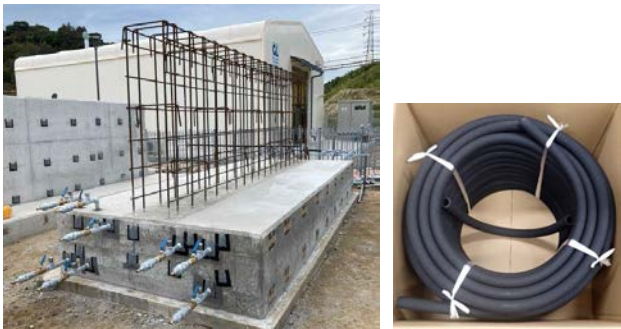
写真－1 実証試験体および CO 2 透過パイプ
