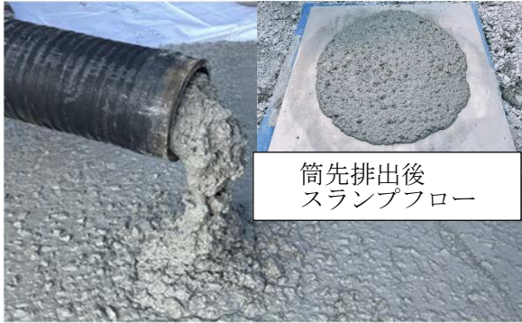
写真-2 筒先排出状況とスランプフロー
