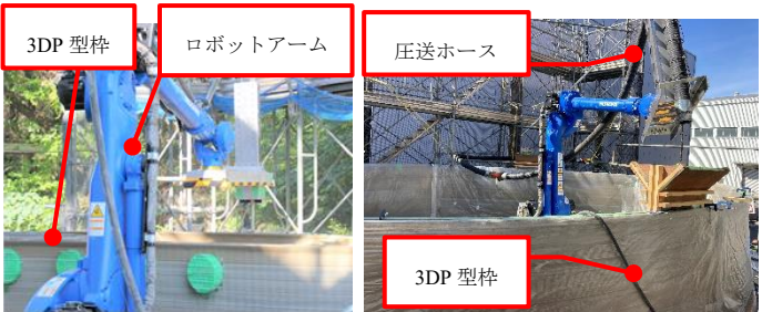
写真-1 型枠プリント
