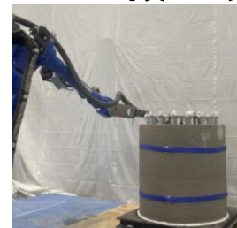
写真-6 打込み状況
