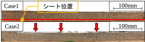
図-2 ひび割れ状況 (下地材による拘束の影響)
