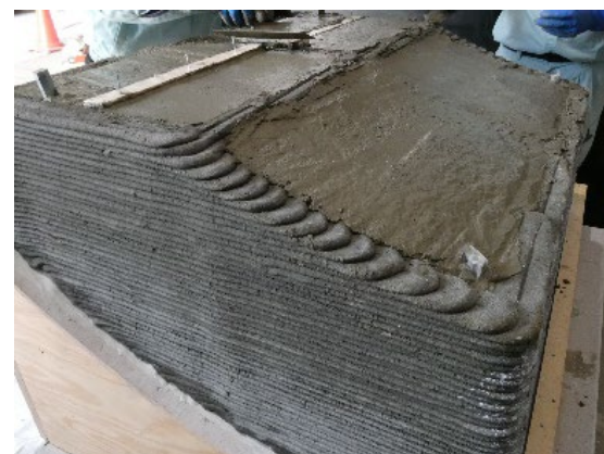
図-7 コンクリート打込み後の状況
