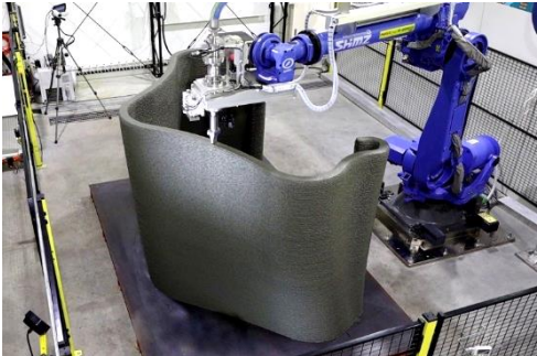
写真-2 3D プリンティングの状況
