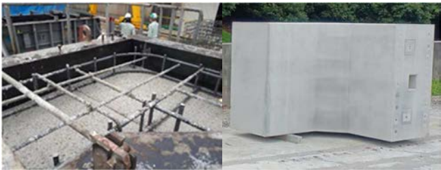
写真-1 製造状況 写真-2 脱型後製品
