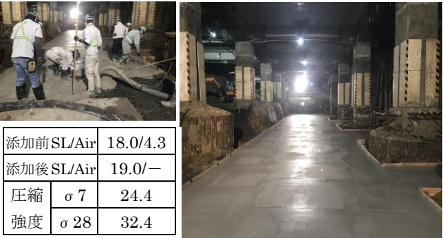
図-5 現場適用・打設状況 (写真:JR 東日本撮影協力)
