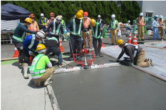
写真-1 UHPFRC 打込み状況
