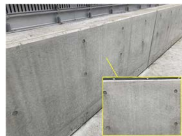
写真-3 打設後の外観
