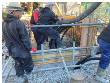
写真-2 打込み状況
