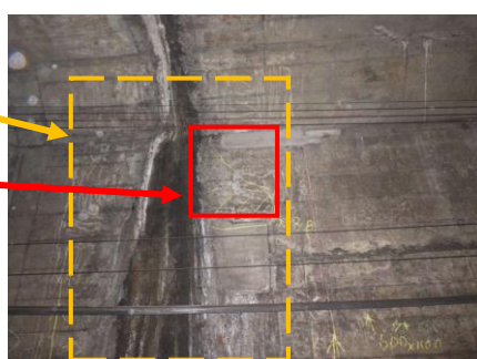
写真-3 はく離 (B, \beta ) 表面含浸材のみ箇所 (B 線 12k595m)
