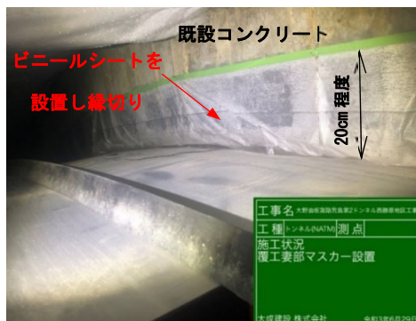
写真3 目地部縁切り状況 (ステップ②, ③)
